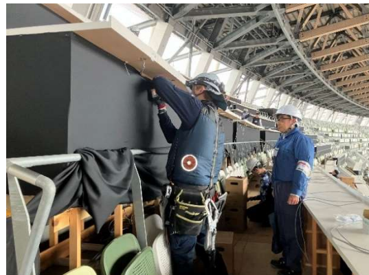
【メディア用仮設ネットワークの敷設作業】
