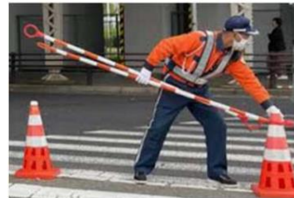
▲ 交通規制資材設置
